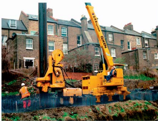
◀ 海外施工現場 (ロンドン)
