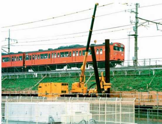
◀ GRBシステム (近接絶対安全工法)
